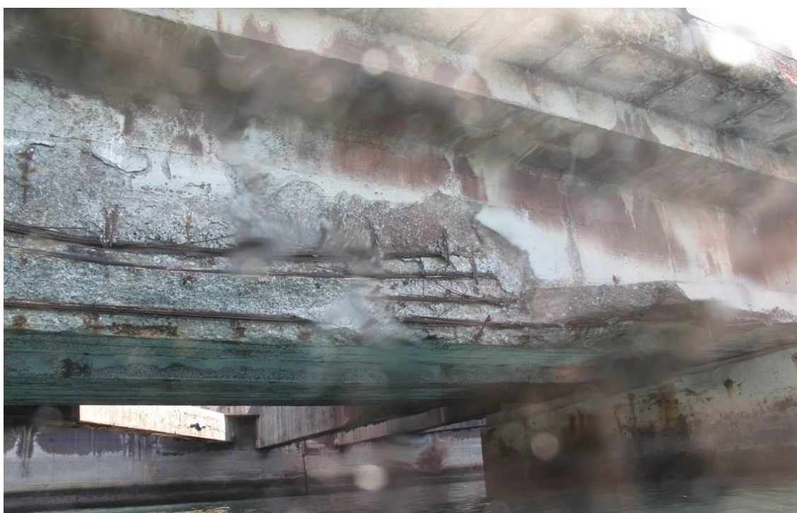
Fotografije br. 1 do 3 – Izrazito jako oštećenje glavnog uzdužnog nosača u polju 31-32 (ošt. 75) – vjerojatno udar broda (ošt. C+)
