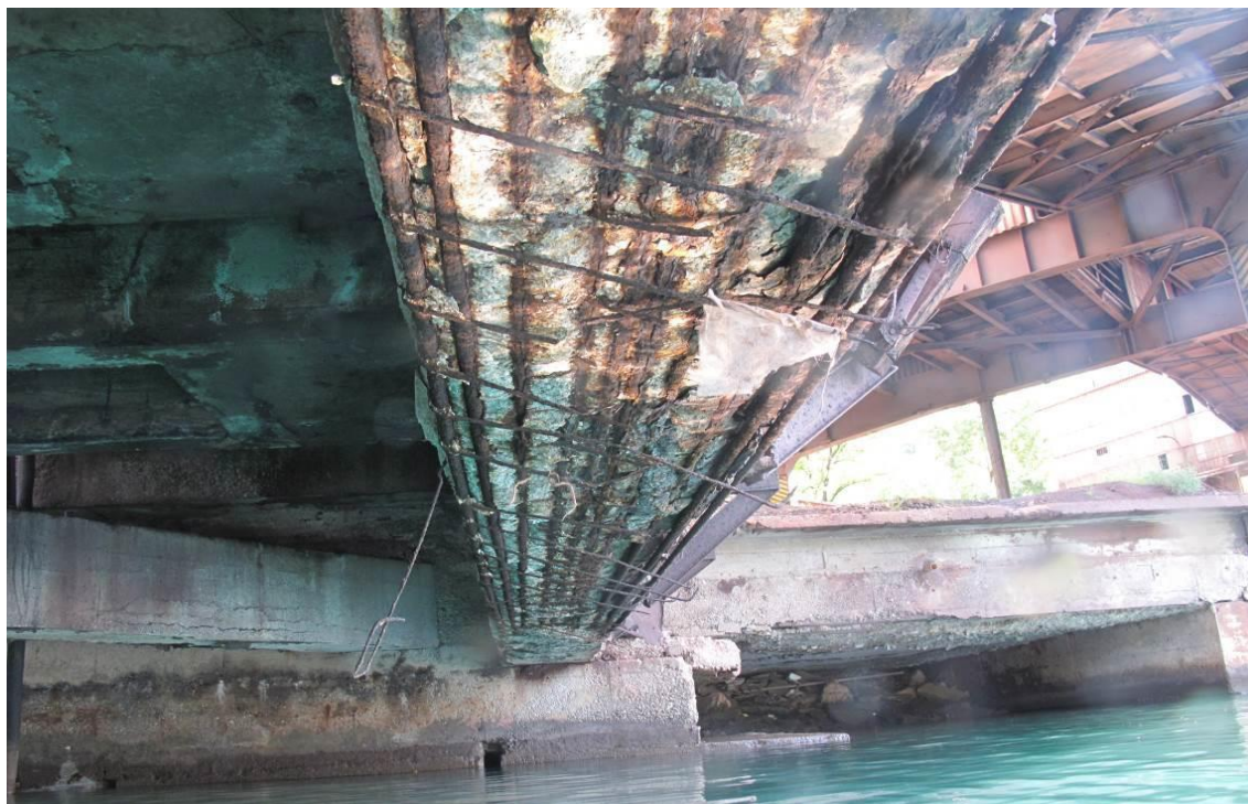
Fotografije br. 7 i 8 – Vrlo jako oštećenje vanjskog glavnog poprečnog nosača u osi 36 (ošt. 89) – potpuno oslobođene šipke cijelom dužinom (ošt. C+)
