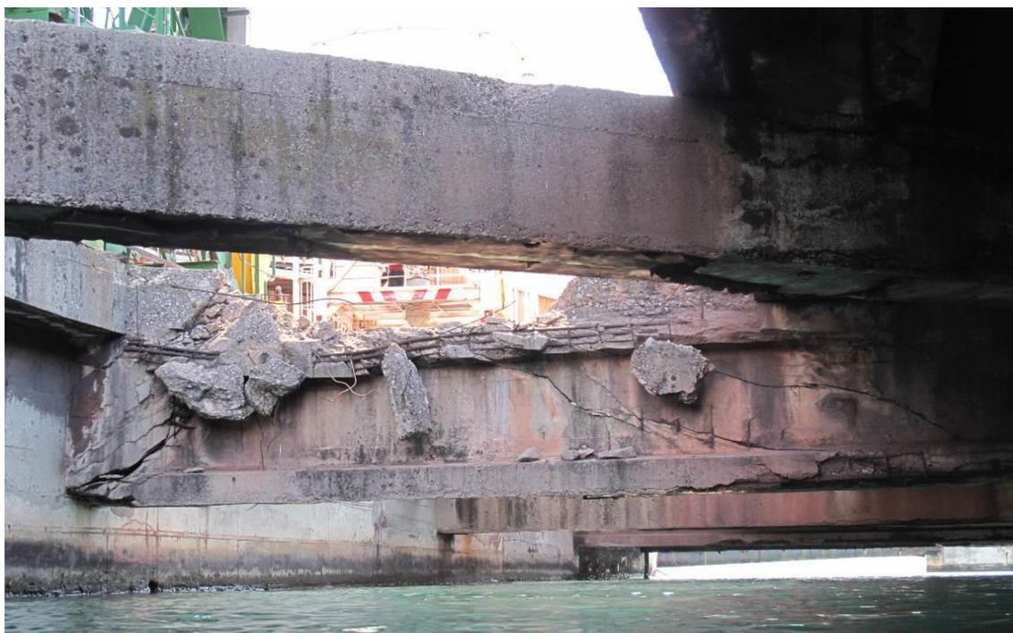
*Fotografije br. 4 do 6 – Vrlo jako oštećenje glavnog poprečnog nosača u osi 33
